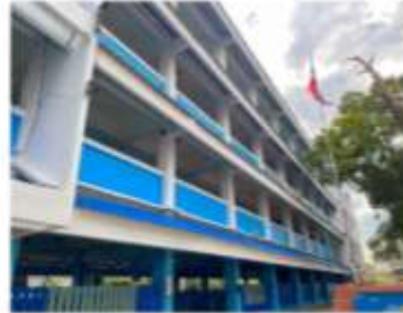
อาคารเรียน 108 ล/30 ปีที่สร้าง 2538
