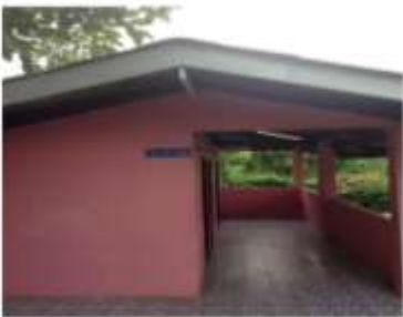
ส้วม สปข.601/26 ปีที่สร้าง 2535
